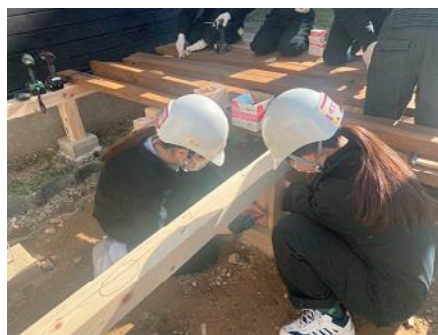
写真4 ウッドデッキ作業の様子
