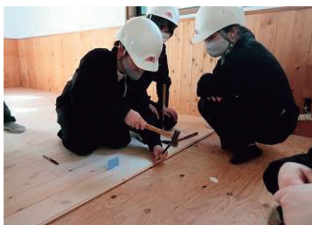
写真1 フローリング張り作業の様子
