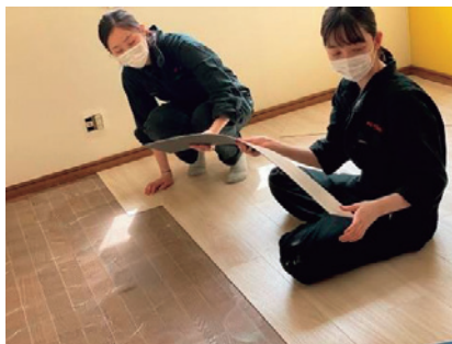
写真2 フロアタイル貼り
