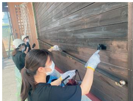
写真2 外壁塗装作業の様子
