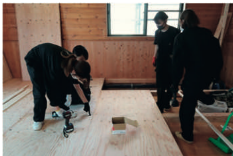
図2 床下地作業の様子
