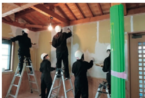
図4 漆喰塗り作業の様子
