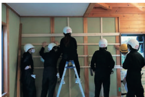
図3 壁下地作業の様子
