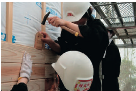
図1 外壁張り作業の様子
