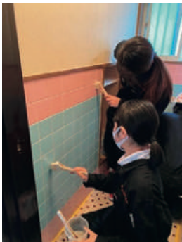
図2 タイル塗装工事
