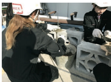
写真1 花ブロックの設置
