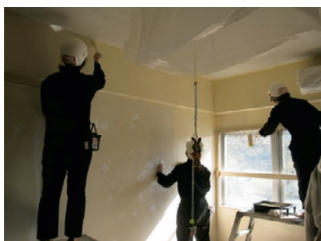
写真2 壁・天井下地工事
