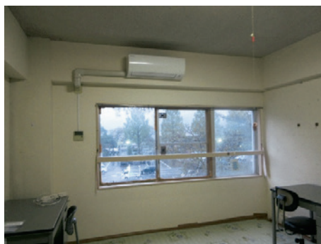
写真1 リフォーム前の寮室
