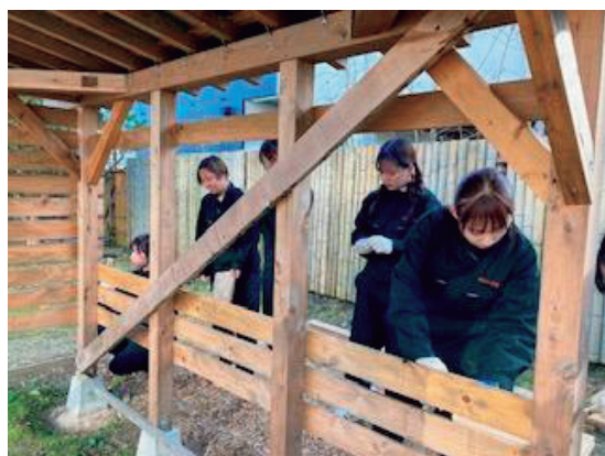
図 6 壁板の取付け
