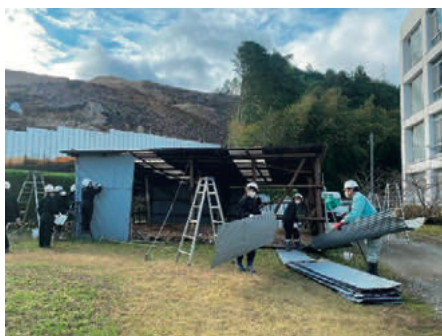
図 3 作業小屋の解体作業の様子
