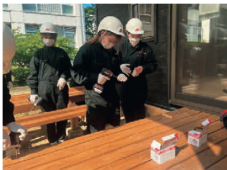
図 1 ウッドデッキ作業の様子
