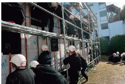
図 3 外壁撤去作業の様子
