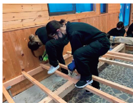
図 4 床組み作業の様子
